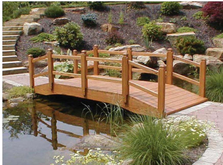
Gambar 2 Jembatan dari kayu
